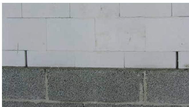
KUVA 23. Kuorimuurin liitos sokkeliin
