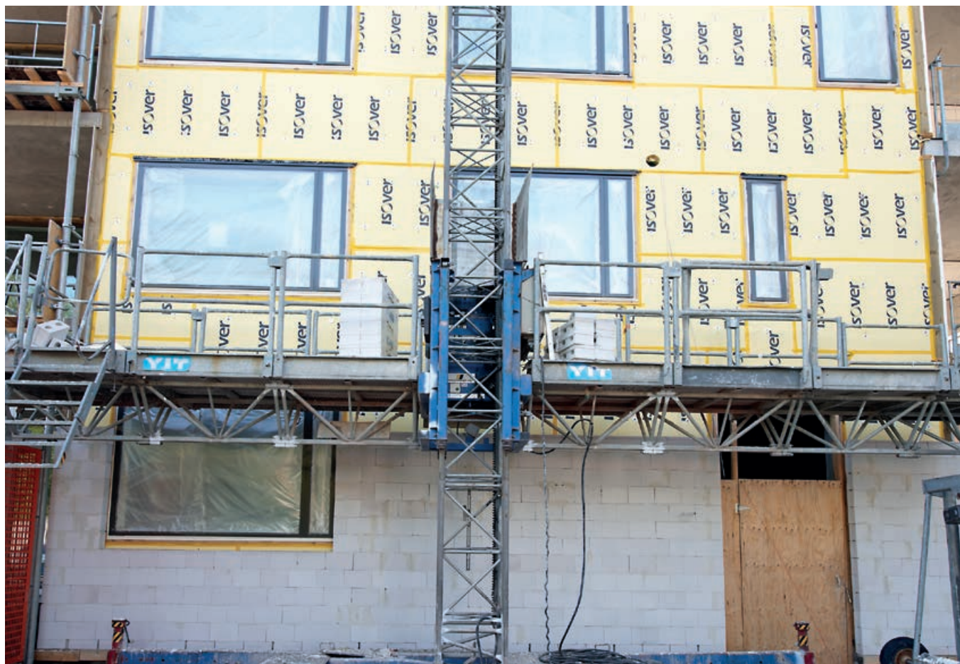
KUVA 24. Kahi Facade -julkisivurakenteen toimivuus on testattu taulukossa 24 mainituilla laasteilla. Rakenne on läpäissyt vaativan 100 kierroksen jäädytysulatus-testin.
