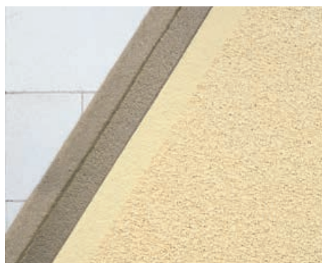
KUVA 25. Kaksikerrosrappaus, rakennekerrokset
